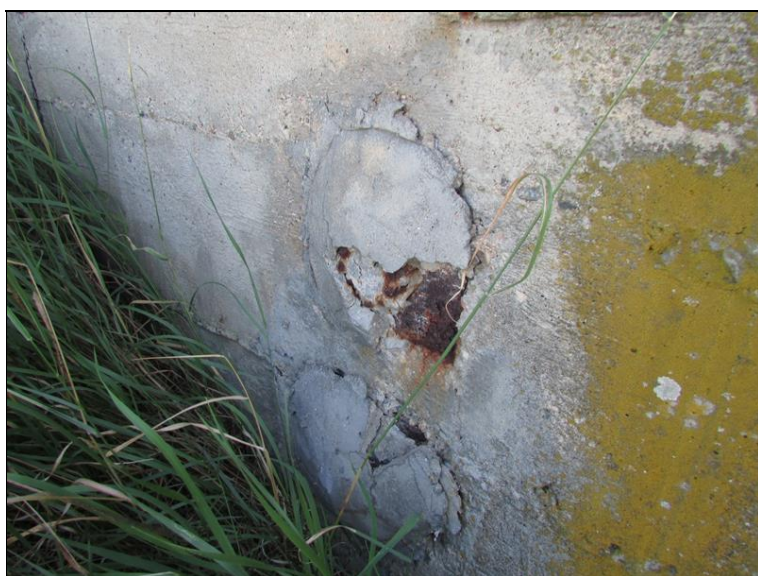
Koroze kotev příčného předpětí OP2
