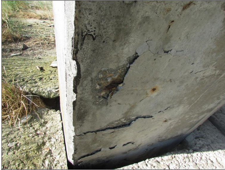
Beton vzpěr se v patě loupe a odpadá
