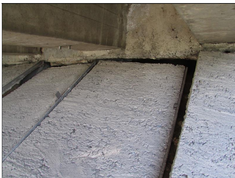
Posunutě desky odláždění svahu u OP2
