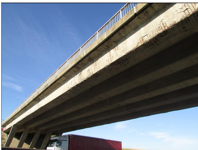
Obnažená korodující výztuž NK
