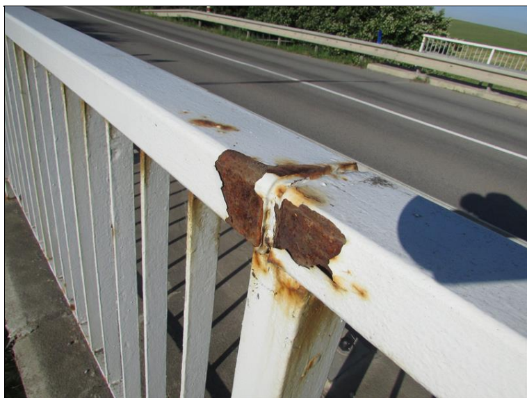
Koroze prvků zábradlí
