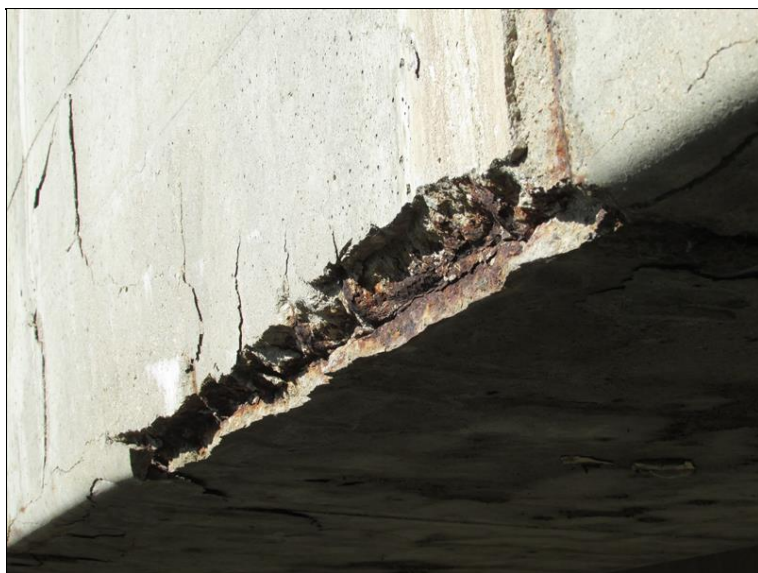
Obnažená korodující výztuž NK
