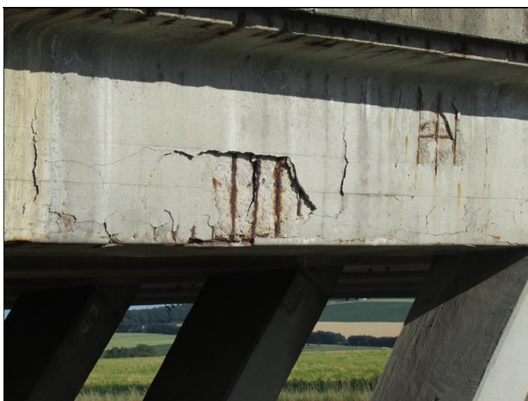
Obnažená korodující výztuž NK
