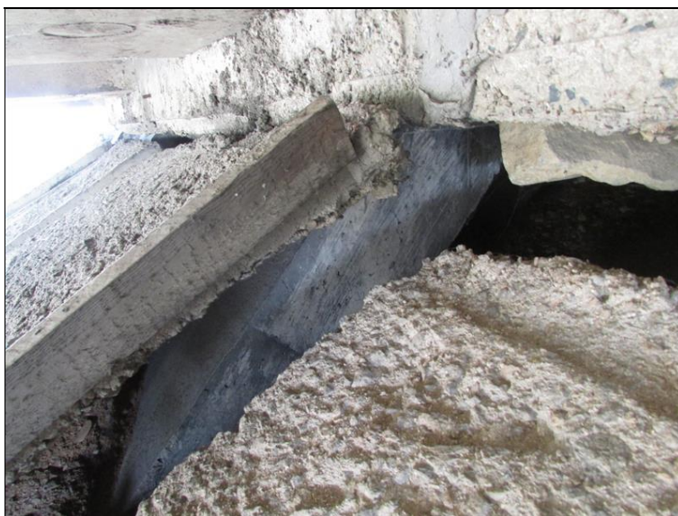
deska odláždění svahu leží na vzpěře OP2
