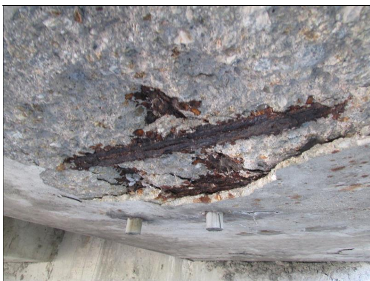
Obnažená korodující výztuž NK
