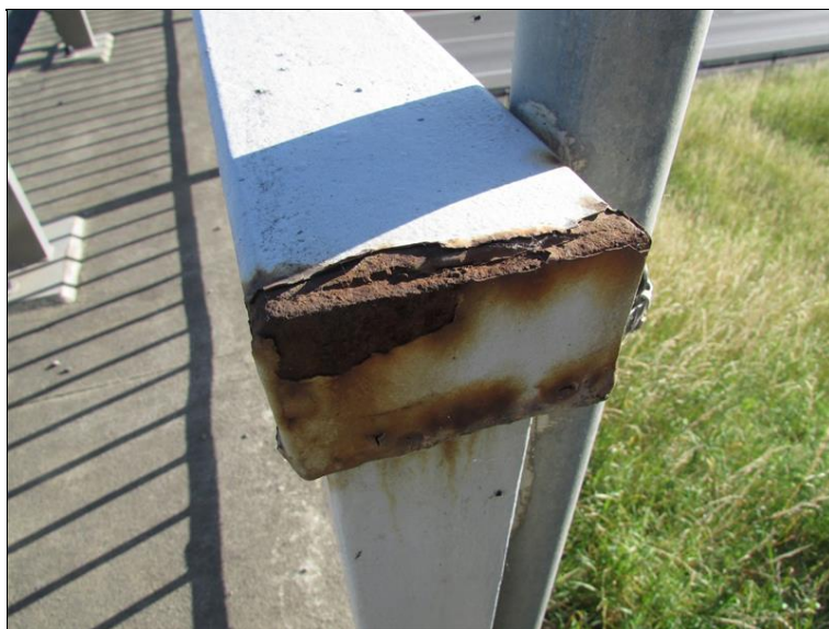
Koroze prvků zábradlí - prokorodovaný sloupek u OP1 vpravo
