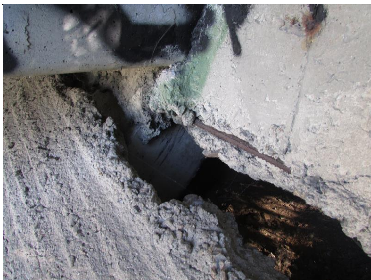
Obnažené vzpěry OP2 pod odlážděním svahu
