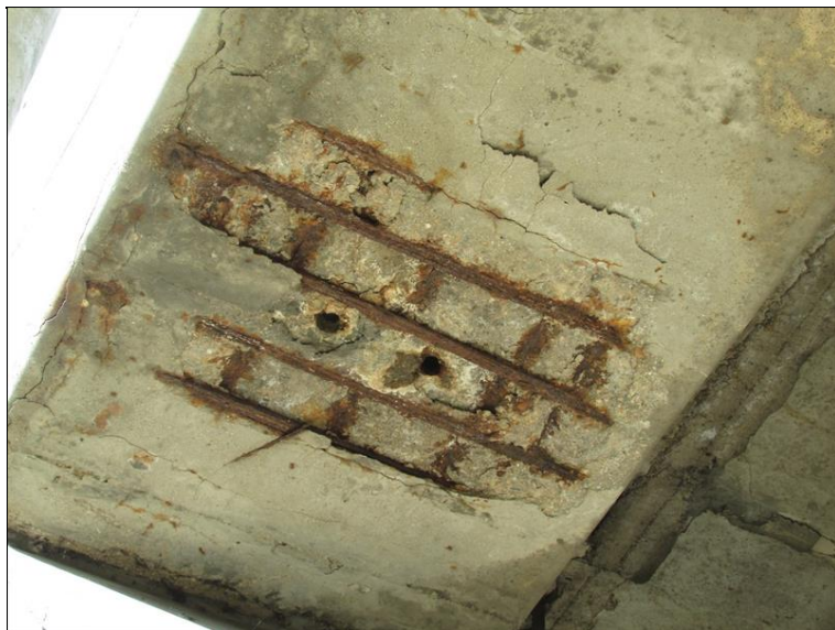
Obnažená korodující výztuž NK
