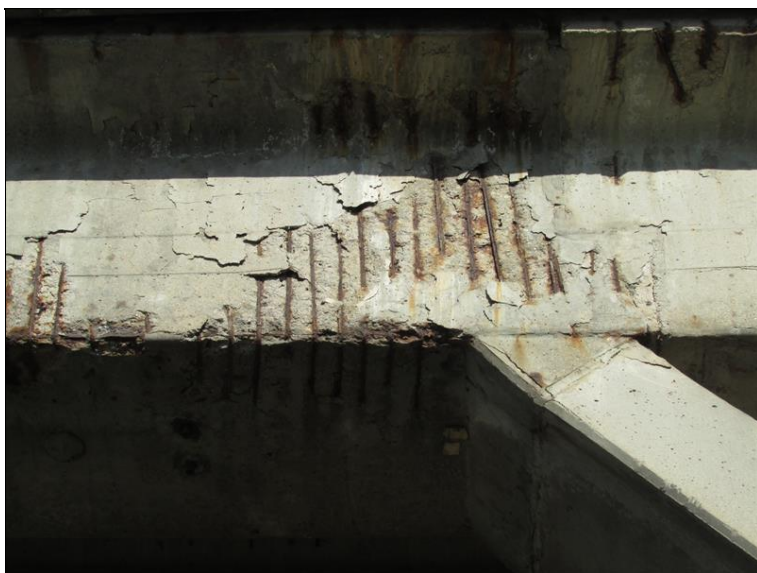
Obnažená korodující výztuž NK
