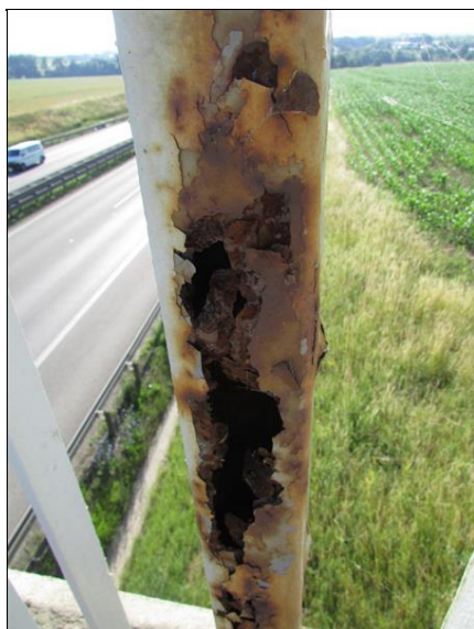
Koroze prvků zábradlí - prokorodovaný sloupek u OP1 vpravo
