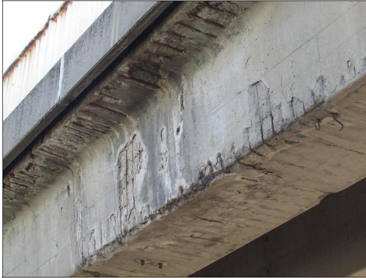
Obnažená korodující výztuž NK
