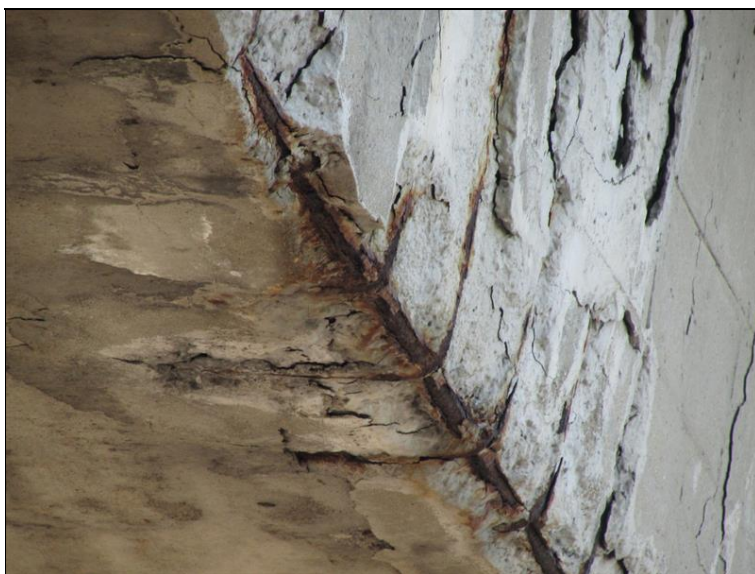
Obnažená korodující výztuž NK
