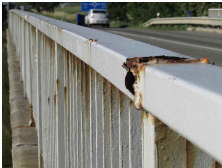
Koroze prvků zábradlí - madlo
