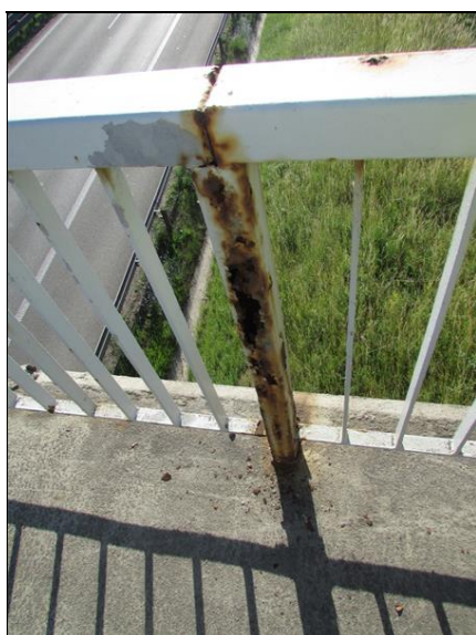
Koroze prvků zábradlí - sloupek
