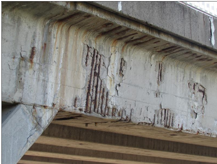
Obnažená korodující výztuž NK
