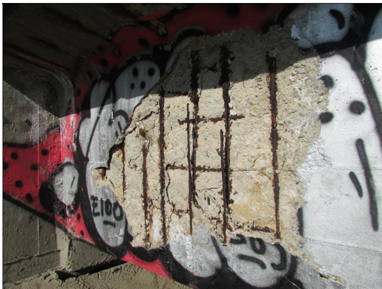
Obnažená korodující výztuž NK
