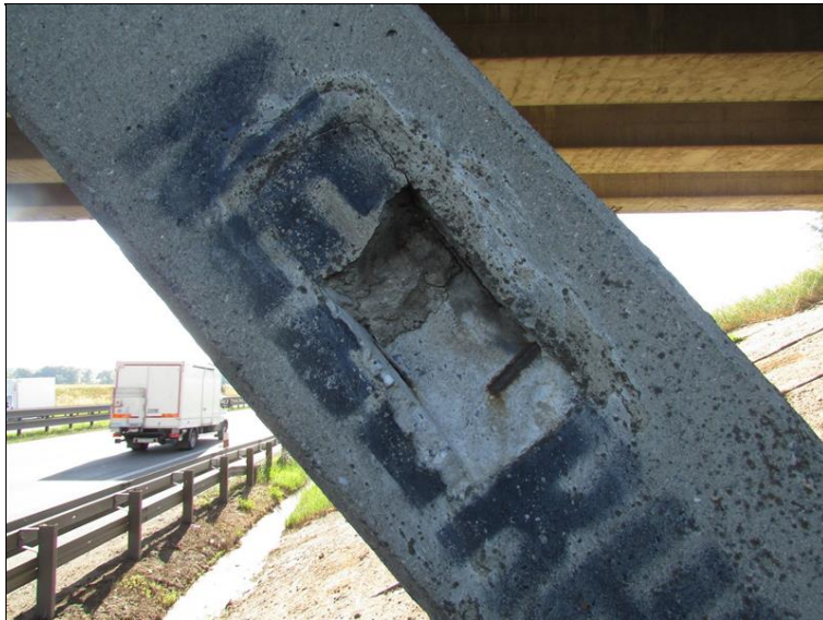
Zabetonovaná kapsa ve vzpěře u OP1
