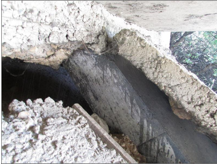
Terén v místě vzpěr je vymletý a žb desky odláždění svahu leží na vzpěrách
