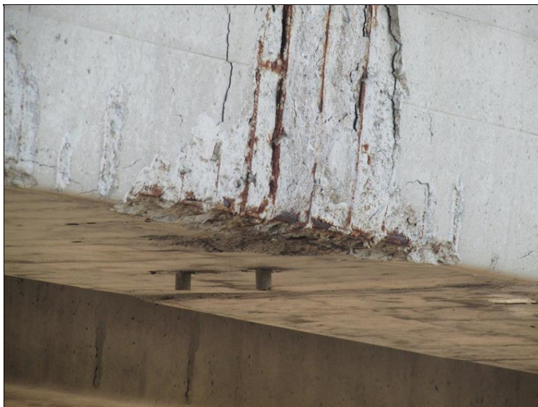
Obnažená korodující výztuž NK
